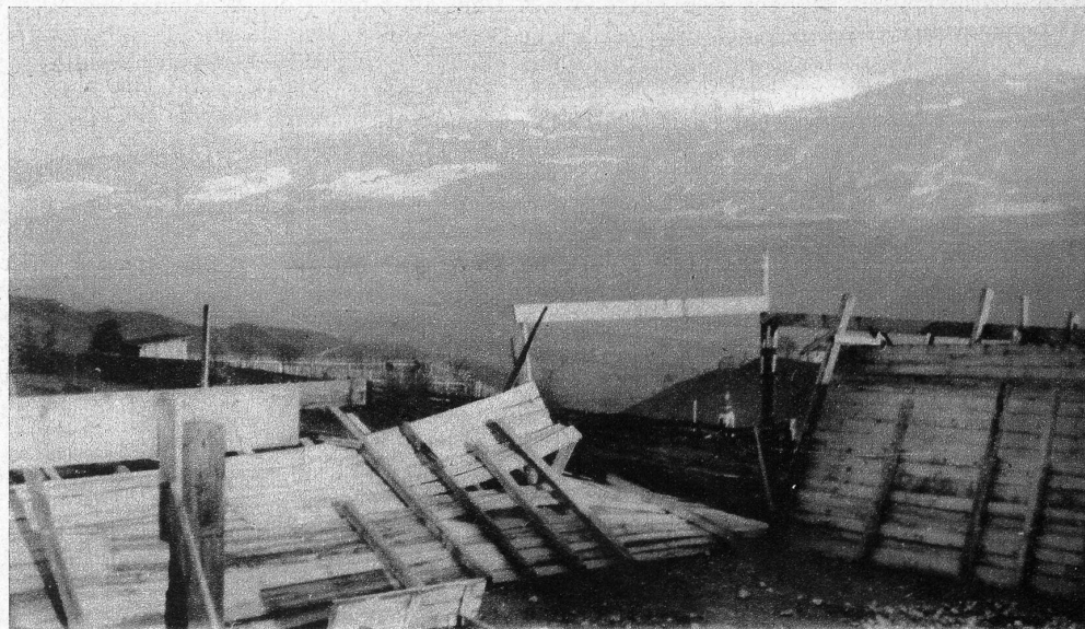
Noch ein Werk der Schweizer Spende: Auf der Anhöhe Schönblick in Arzl oberhalb Innsbruck bauen österreichische Arbeiter unter Leitung von Fritz Keller ein Säuglingsheim für 46 Säuglinge. Der Kredit der Schweizer Spende hierfür beträgt 80 000 Franken. Das fertige Heim wird nachher vom Schweizerischen Arbeiterhilfswerk übernommen und ein Jahr lang geführt, dann wird es der Stadt Innsbruck geschenkt
