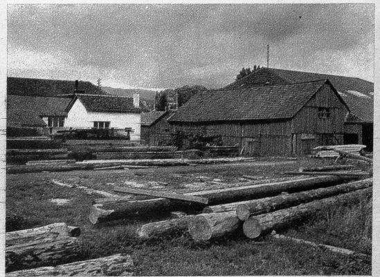
Ansicht eines Teils des Holzlagers, mit den Gebäuden des Betriebes
