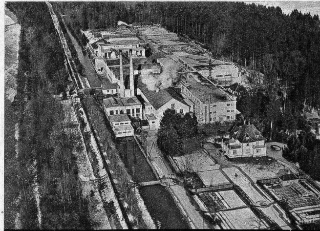
Gesamtansicht der Fabrikanlage aus dem Jahre 1936
