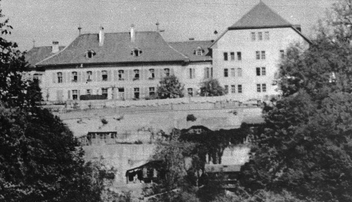
Ansicht der Strafanstalt von der Zufahrtsstrasse her. In der Mitte das Verwaltungsgebäude.
