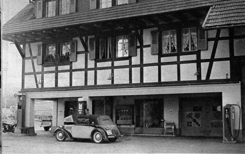
Die Tankstelle Tiefenau
