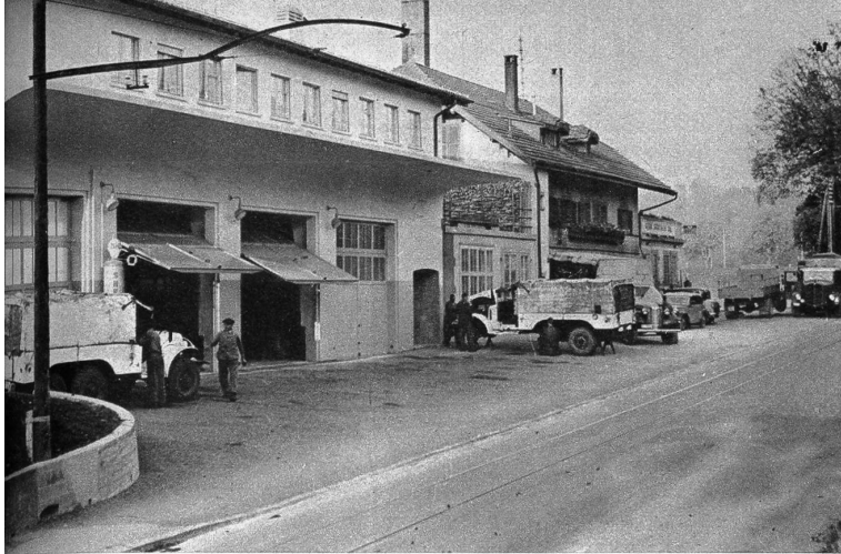
Das neue und das alte Werkstattgebäude (Photos W. Nydegger)
