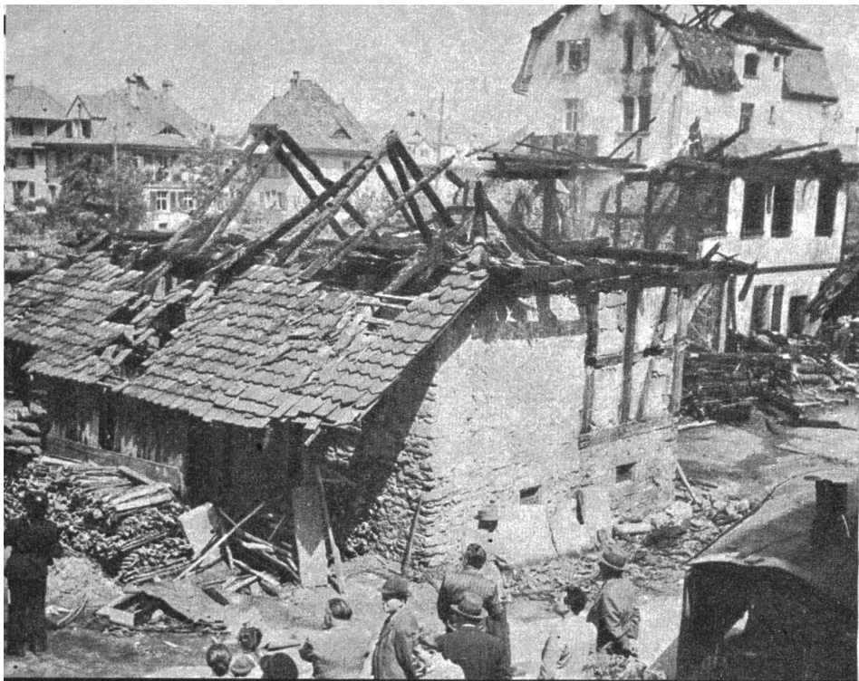
In der Nacht zum vergangenen Freitag brach in der Farbasse in Langenthal im Hause des Landwirtes Aebi ein Brand aus, der, durch die herrschende Bise begünstigt, rasch auf andere Gebäude übergriff. Trotz der Zusammenarbeit der Feuerwehren von Langenthal und der umliegenden Dörfer brannten innert kürzester Zeit fünf Häuser, darunter das alte Heilsarmehaus, fast vollständig nieder. 13 Familien mit 45 Personen sind obdachlos geworden. Unser Bild zeigt die Unglücksstätte am Morgen nach dem Brand
