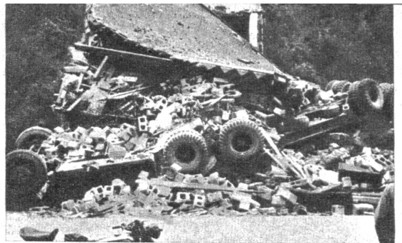
Das «Wunder von Dinant». In Dinant in Belgien verlor ein Lastwagenchauffeur die Herrschaft über seinen mit Langholz beladenen Wagen, der ein in einer Kurve stehendes Haus rampte, das durch den wuchtigen Zusammenstoss vollkommen zerstört wurde. Das Haus war zur Zeit des Unglücks von der Familie Michel-Warnon bewohnt. Obschon Vater, Mutter und die zwei Kinder unter den Trümmern begraben wurden, erlitten sie nicht die geringste Verletzung. Aber auch der Chauffeur, den man nach zweistündigen Bemühungen bergen konnte, kam mit dem Schrecken davon
