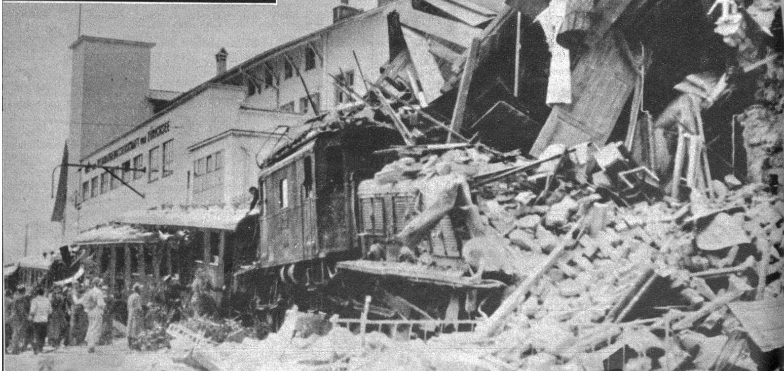
Der Katastrophenort. Rechts im Bilde das eingestürzte Gebäude (Photopress)
