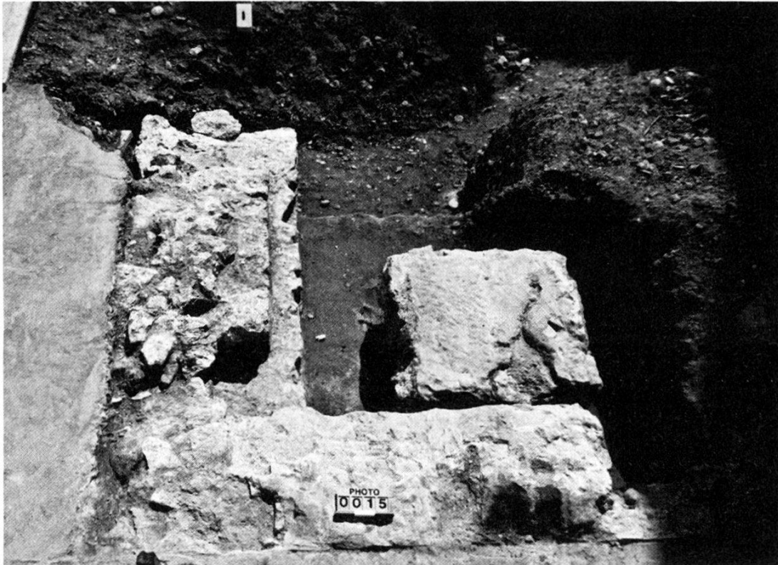
Abb. 6. Rheingasse 47: Blick durchs Reverenzgäßlein Richtung Rhein in die östliche Fundamentecke der Fäbrestation (vergleiche Photowinkel auf Abb. 4). In die Ecke gestellt der später eingebaute Fundamentklotz A. Unmittelbar davor lag das Profil Abbildung 7 mit dem markanten Störungssack.
