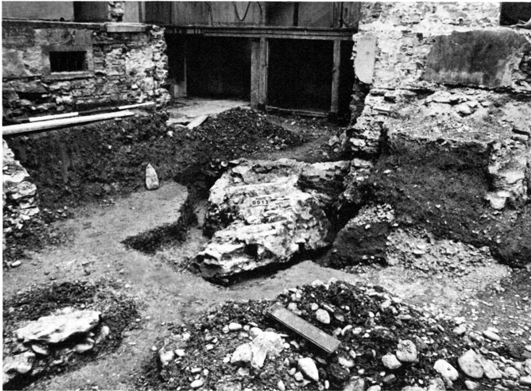
Abb. 5. Rheingasse 47: Blick vom Reverenzgäßlein Richtung Westen auf den verkippten, rheinwärtigen Fundamentzug (vergleiche Photowinkel auf Abb. 4). Auch hier sind die Balkenverstärkungen deutlich zu erkennen.
