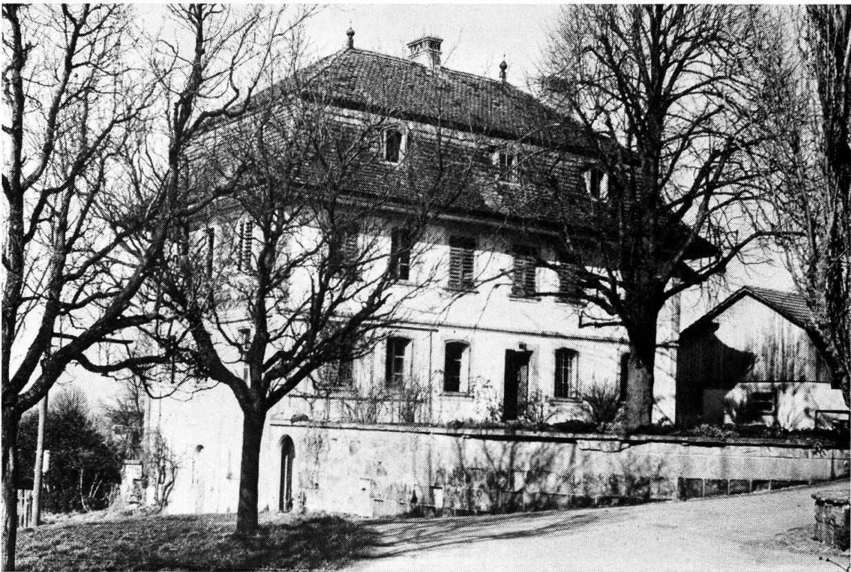
10. Litzistorf, Landhaus des 18. Jh. Der prächtige, aber vernachlässigte Bau steht leer und soll abgebrochen werden.
