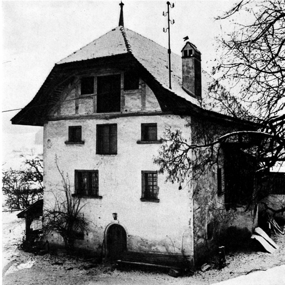
3. Rechthalten, Herrschaftshaus im Unterdorf, Ansicht aus Nordwest. Rechts, knapp sichtbar die Holzgalerie zum Nebengebäude, im Vordergrund angeschnitten Dach eines der Wirtschaftsgebäude.
