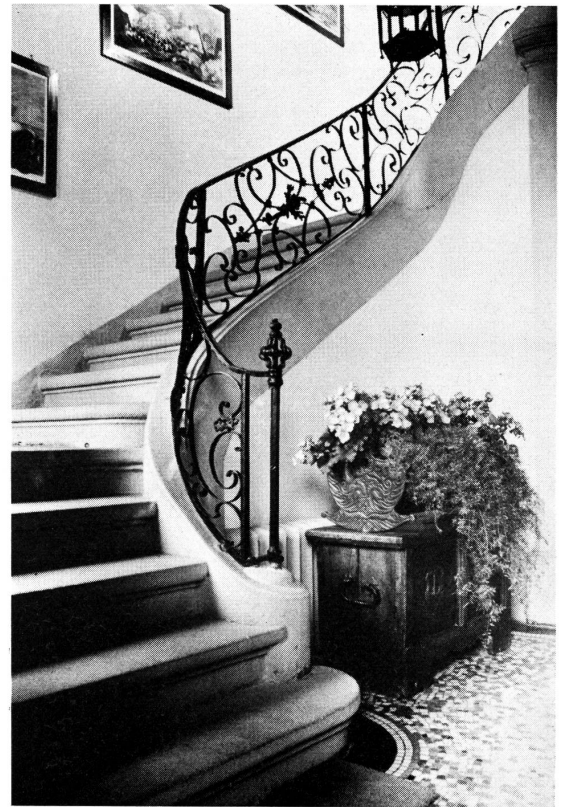
12. Vogelshaus, geschweiffter Treppenaufgang. Prachtvoll gearbeitetes Eisengeländer, welches die elegante Linienführung der Treppe unterstreicht.
