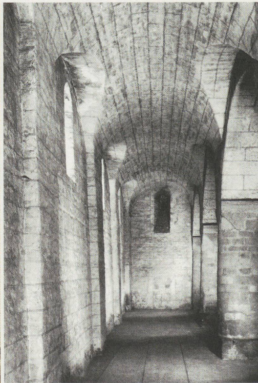
FIG. 28 — La fenêtre raccourcie, dans le mur ouest du bas-côté sud
