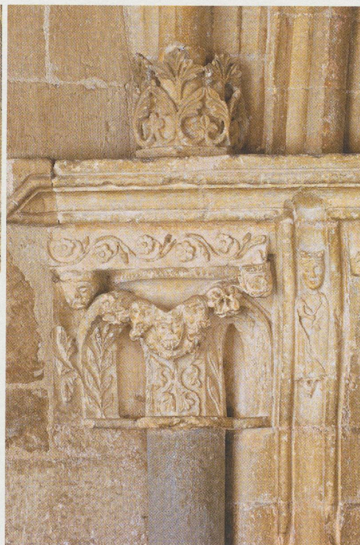
FIG. 60 — Détail de l'ébrasement gauche du portail
