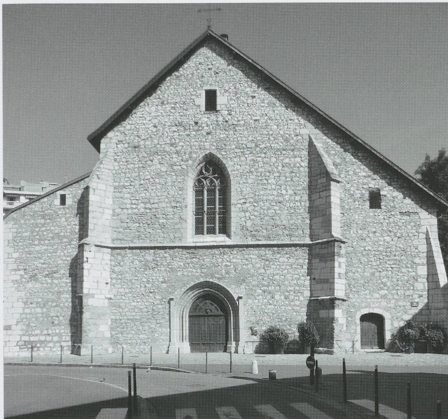
Fig. 245. L'ancienne église des Dominicains d'Annecy. La façade de la nef élargie après coup par les faces occidentales des chapelles et achevée à la fin du XV e siècle (photo MG, 2013).
