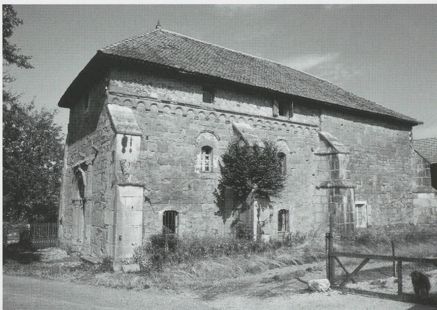
Fig. 222. La chapelle de Moussy (Cornier). L'extérieur du flanc sud, avec ses soutiens sous forme de contreforts «genevois» épaissis (photo MG, 1979).
