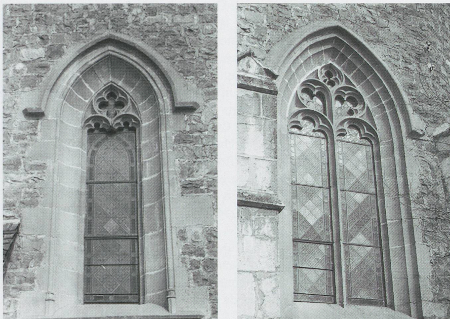
Fig. 410. L'église Saint-Vincent de Montreux. La petite baie du chœur, sans meneau, dans son état ancien (photo MG, vers 1970).
