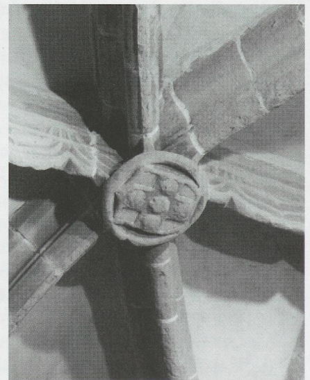
Fig. 474. L'abbatiale de Payerne. La chapelle des saints Fabien et Sébastien, de noble Jean de Goumoëns, vers 1451/1458: une partie de la voûte à lierne en accolades enjolivées (photo MG, 2011).
