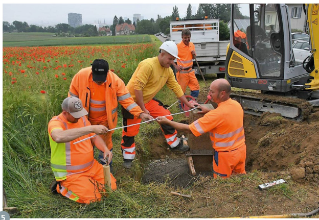
Figures 5 et 6 : contrôle avec le repérage et contrôle final par GNSS. La satisfaction du devoir accompli se lit sur les visages des participants. (© P. Reimann)
