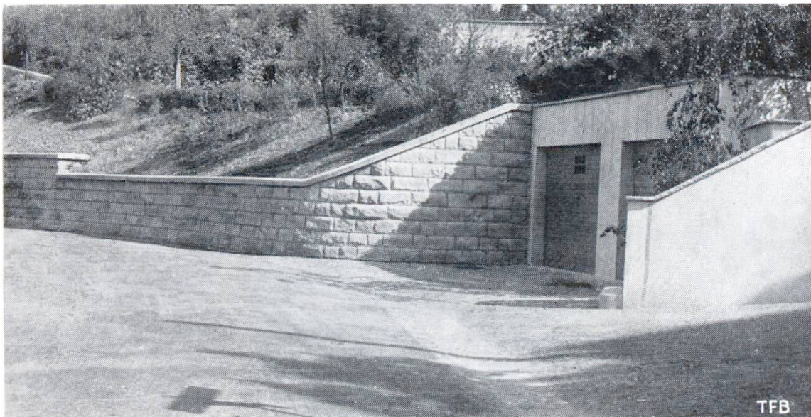
Abb. 8 Stützmauer und Garteneinfassung aus Naturstein und Beton
