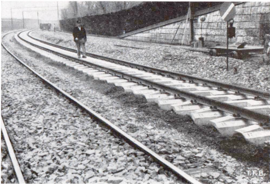
Abb. 7 Versuchsstrecke unter stärkstem Verkehr und in Kurve (Nr. 6213 BRB. 3. 10. 39.)
