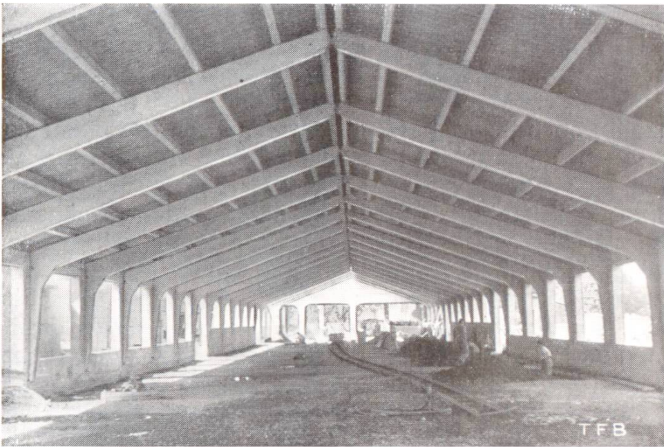
Abb. 3 Dachuntersicht nach der Eindeckung mit Welleternit
