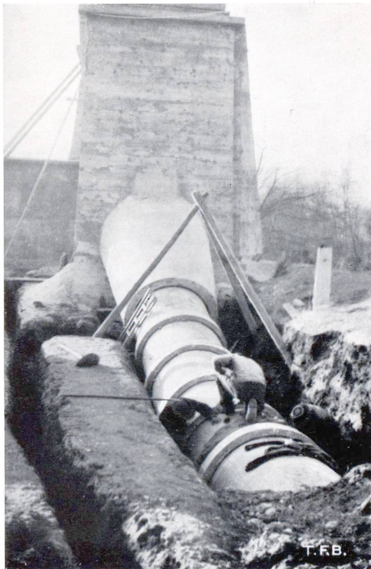
Abb. 2 Anschluss einer Druckleitung an Wasserschloss, 125 cm Durchmesser
