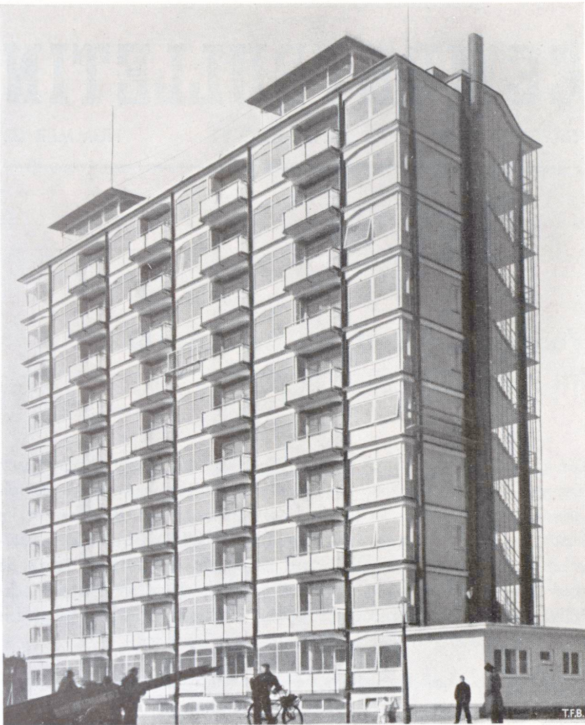
Wohnhochhaus in Rotterdam. Architekten W. van Tijen und H. A. Maaskant. Das Eisenbetonskelett erwies sich gegenüber dem Stahlskelett, das an einem ähnlichen, vier Jahre vorher errichteten Bau erprobt werden konnte, in technischer und speziell akustischer Hinsicht als überlegen. Der Bau enthält 40 Kleinwohnungen
