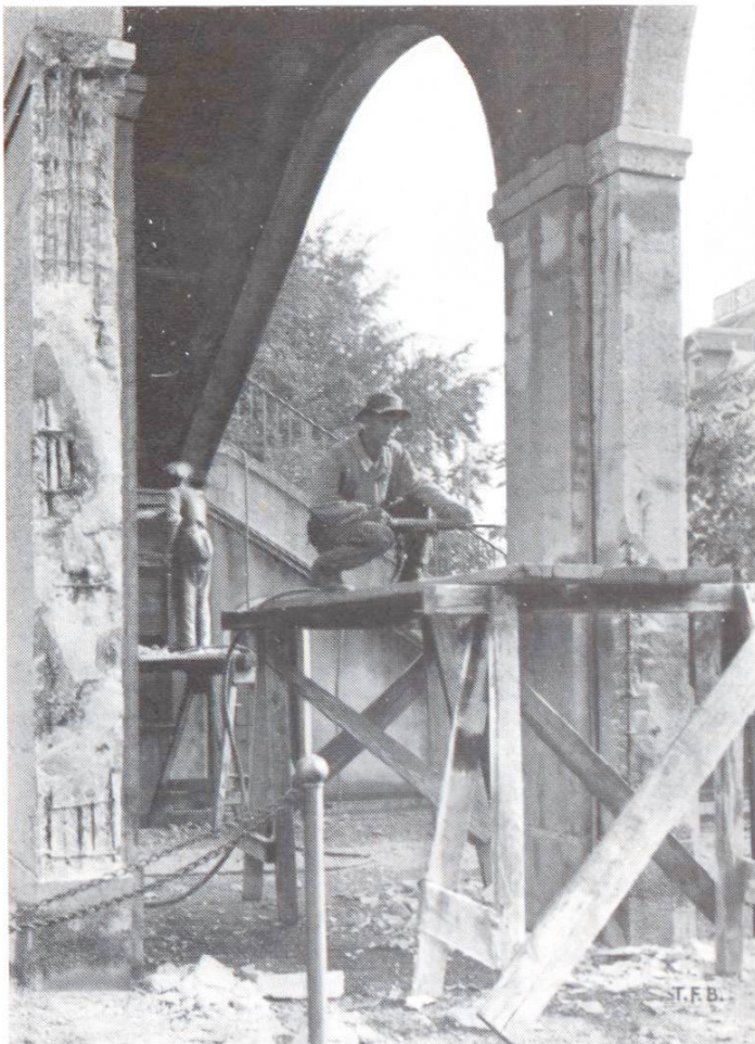
Abb. 6 Instandstellung einer Eisenbeton-Passerelle
