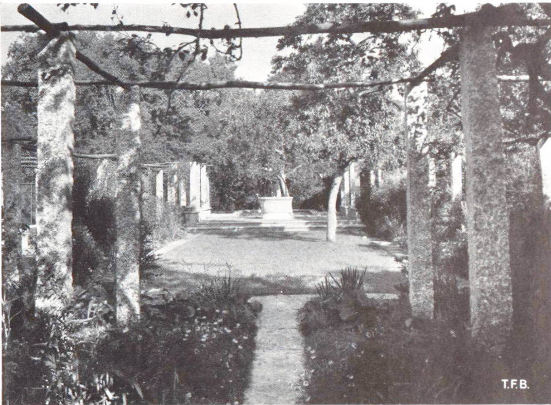
Gespaltene, silbergraue Granitpfeiler tragen krumme Kastanienhölzer zur Aufnahme der Schlinger. Im Hintergrund Pozzo, bearbeitet von Otto Münch
