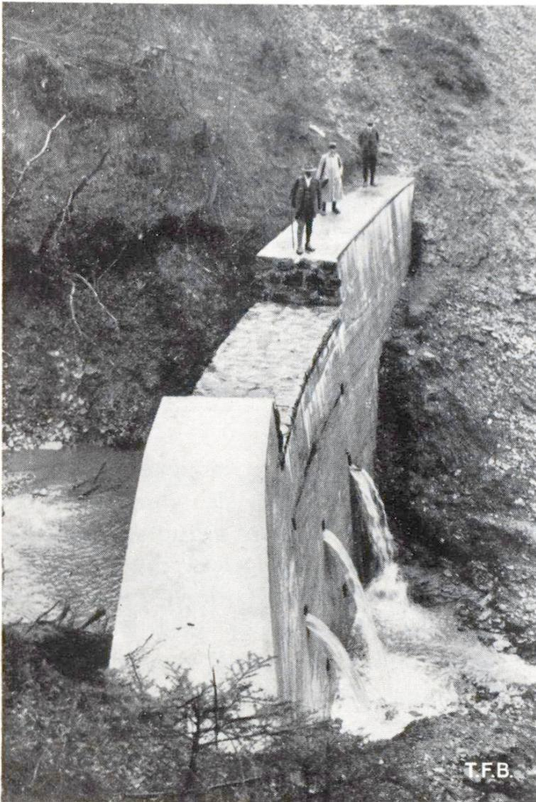
Abb. 5 Sperre in Beton mit Natursteinverkleidung des Überlaufes, kurz nach Bauvollendung; heute mit Geschiebe hinterfüllt; Trübbach bei Trübbach, Kanton St. Gallen
