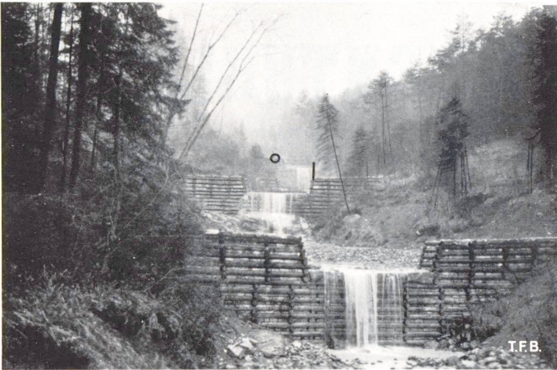
Abb. 1 Sperren in Holzbauweise mit Steinausschlag, am Widenbach, Altstätten
