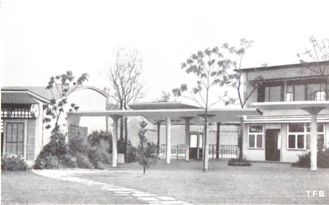
Abb. 7 Freibad Allenmoos, Zürich. Eingangspartie. Rohe Eisenbetonkonstruktionen. Freistehende Pilzdächer für die gedeckten Uebergänge. Links Garderobehalle mit gewungenem Dach in Eisenbeton.
