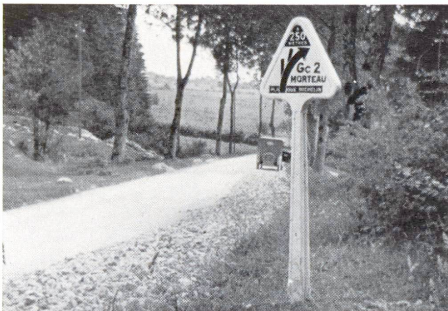
Abb. 4 Der erste Vorwegweiser der Welt, 1930 von Michelin geschaffen, bereits ganz aus Beton
