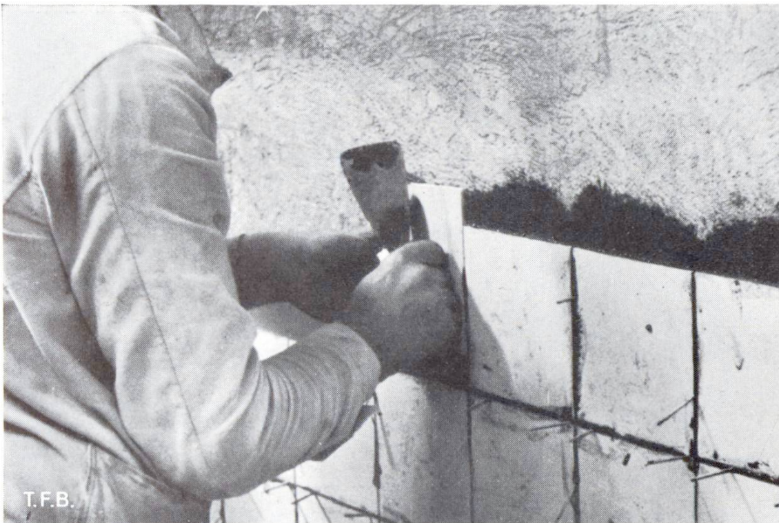
Abb. 5 Versetzen von Wandplatten nach dem Klebeverfahren
