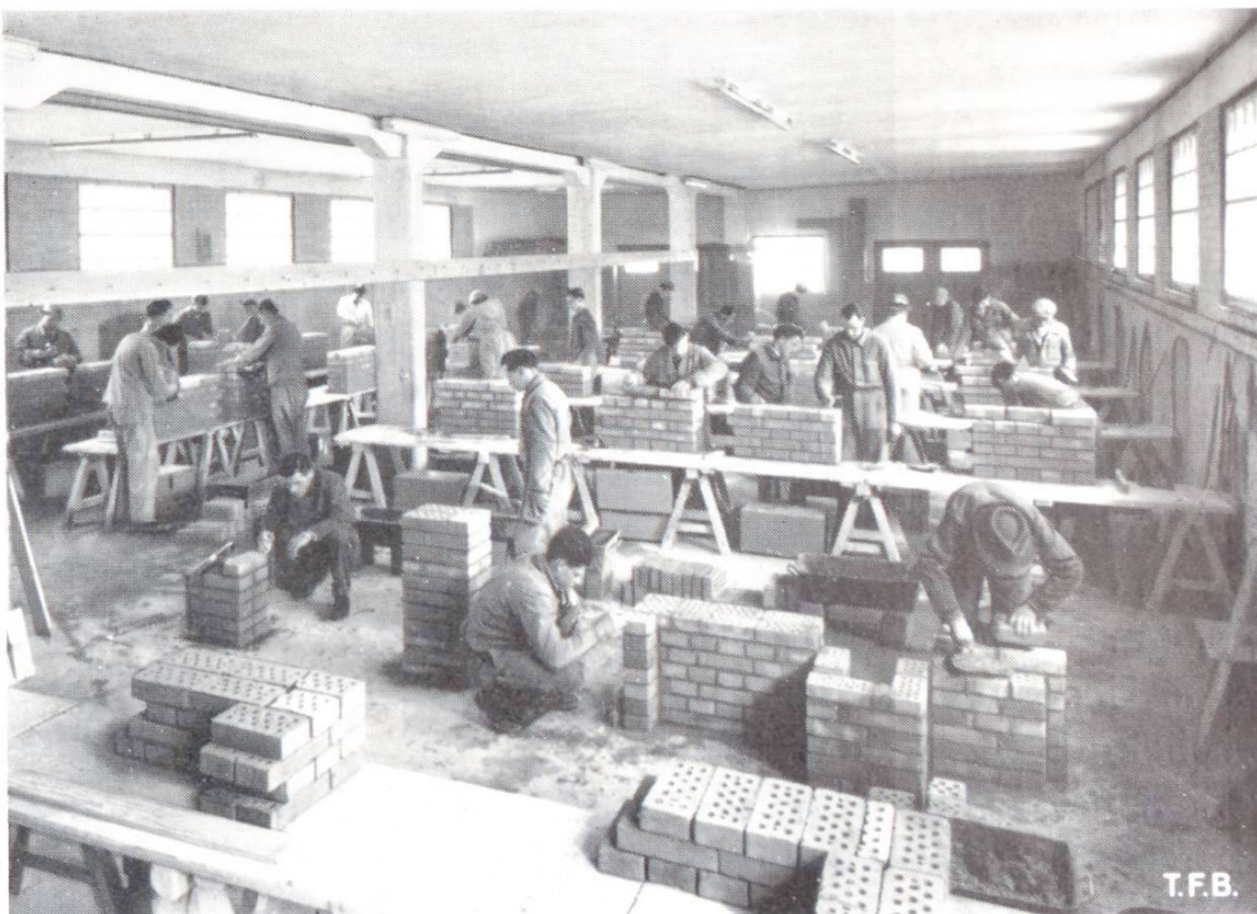
Abb. 3 Innenaufnahme der Lehrhalle Sursee des Schweizerischen Baumeisterverbandes
