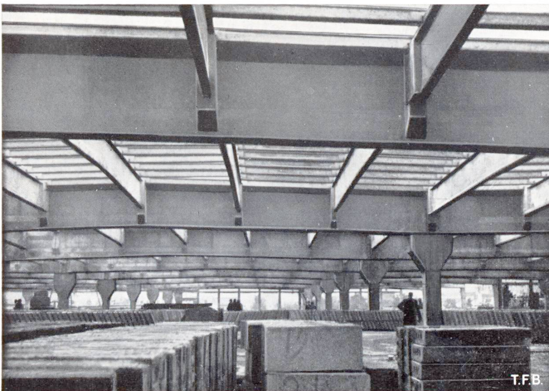
Abb. 8 Baumwollfabrik Gand (Belgien), Innenansicht mit Bindern, Pfeffen und Sparren aus vorgespanntem Beton, System Magnel. Im Gegensatz zu Eisenbeton und wie bei Stahlprofilen wirkt hier der Untergurt statisch mit
