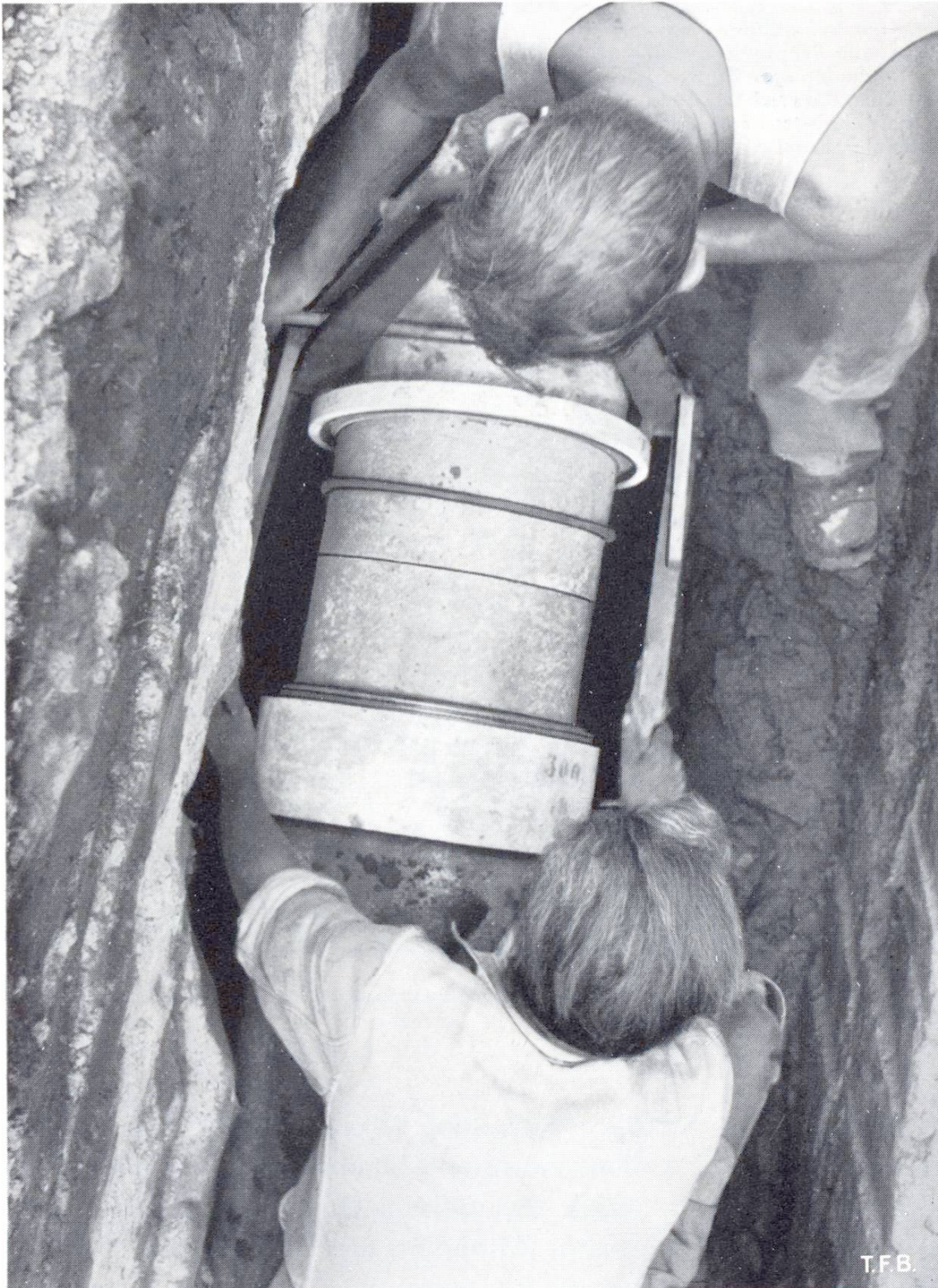
Abb. 7 Bei der Montage einer Leitung von 300 mm \varnothing , 18 Atm. Prüfdruck
