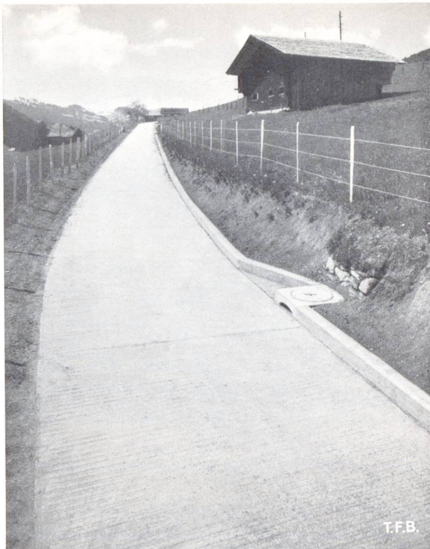
7 Abb. 20 Güterweg bei Rougemont, Baujahr 1951, Breite 2,80 m
