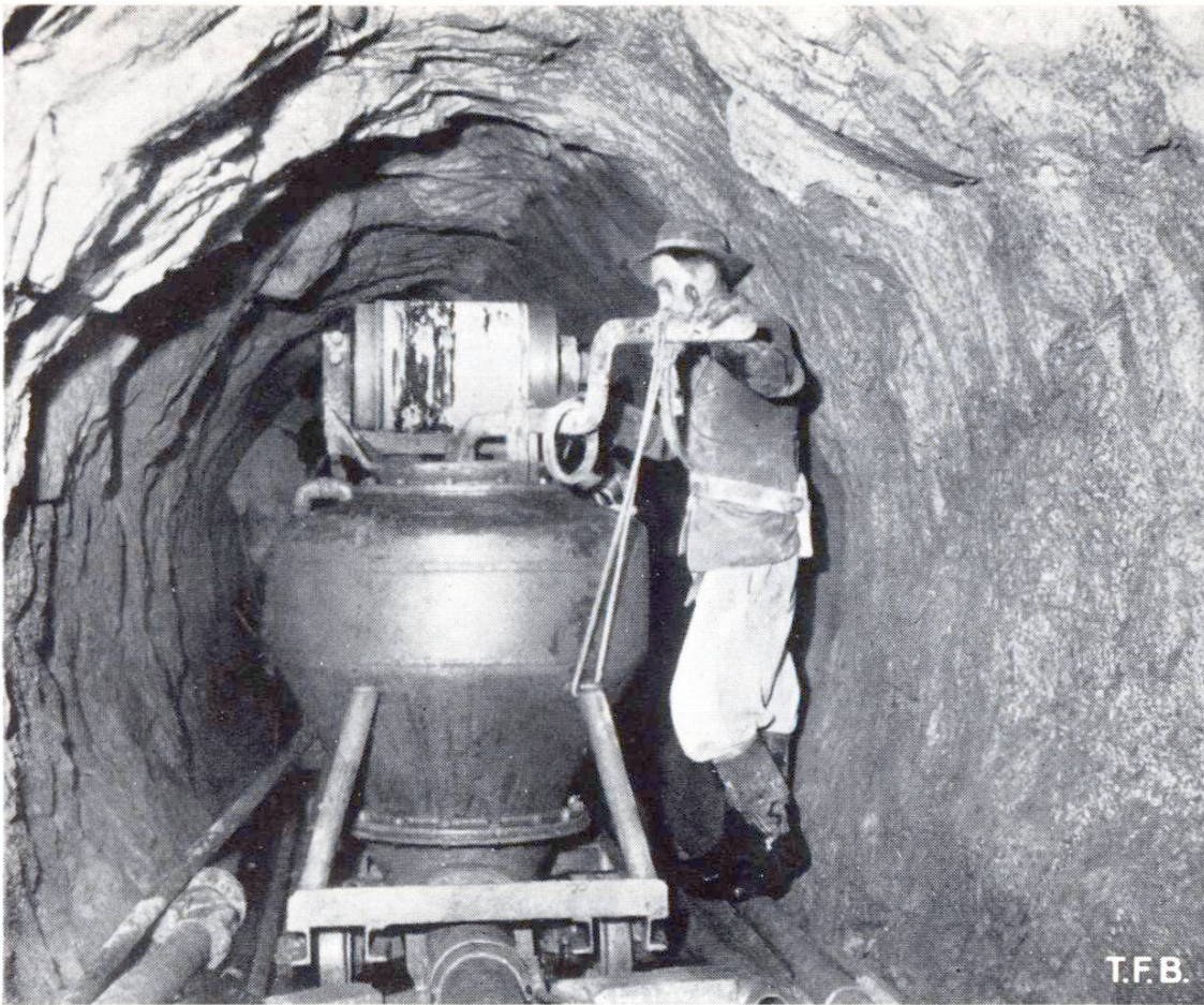
Abb. 4 Betonieren im Druckschacht Oberaar mit dem Jonny
