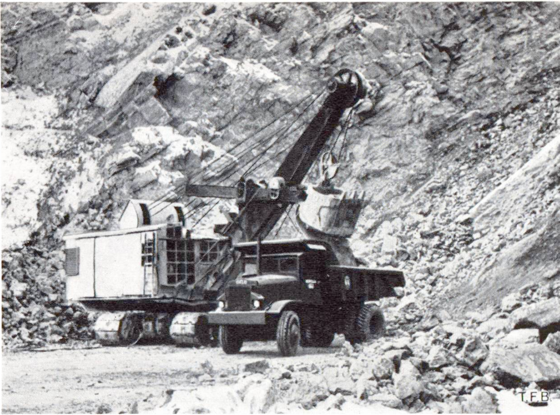
Abb. 7 Elektrischer Bagger mit 2 m 3 Löffel und Speziallastwagen für 15 t
