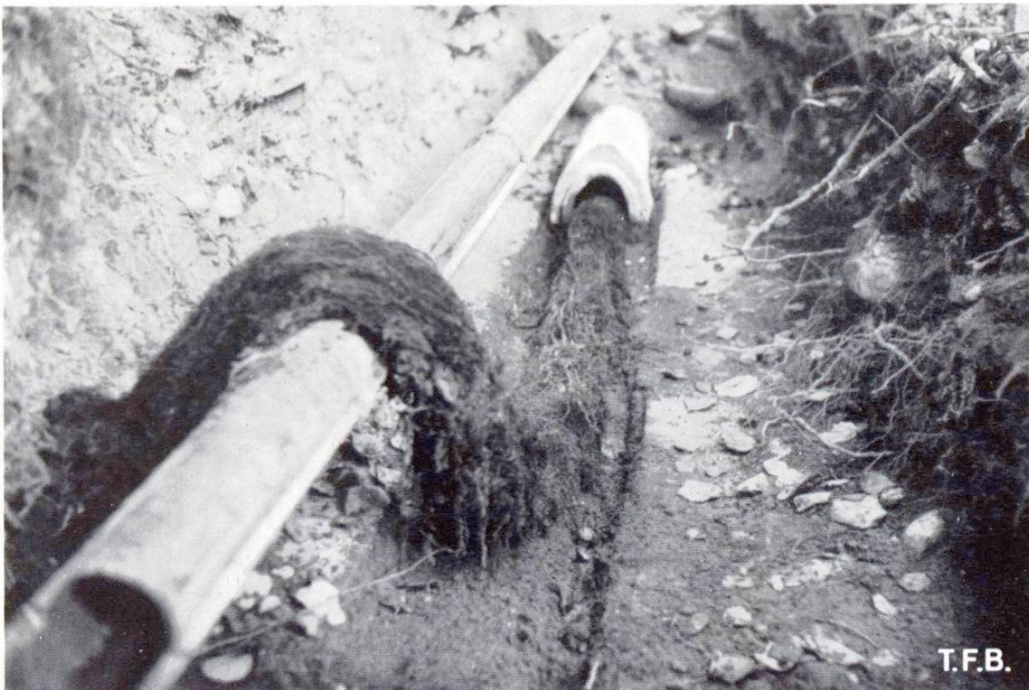
Abb. 2 Wurzelbildung über einem 50 000 Volt Kabel
