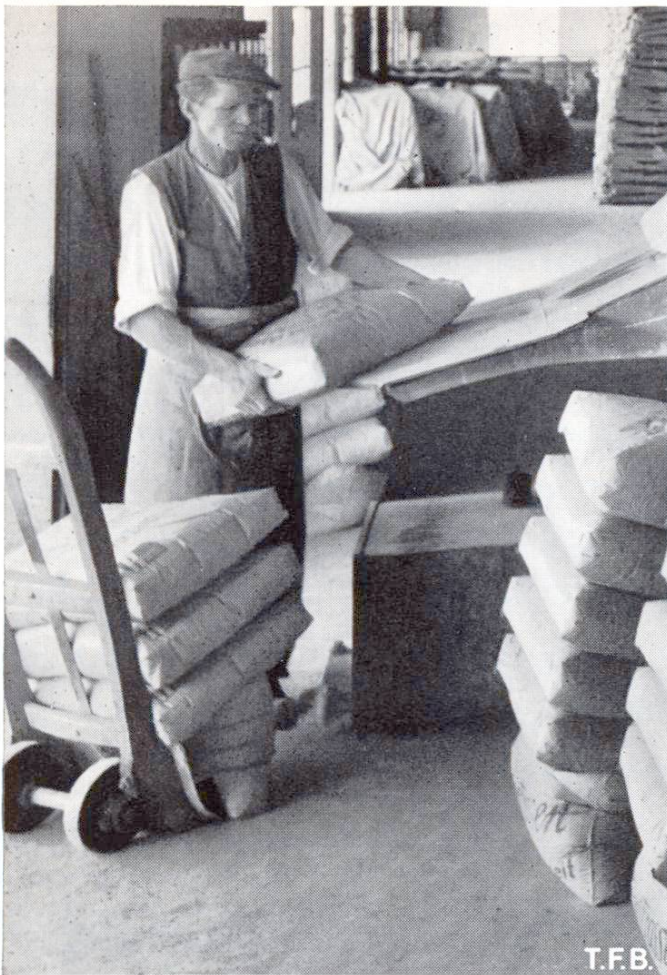
Abb. 3 Transport von fabrikfrischem Cement durch Sackkarren
