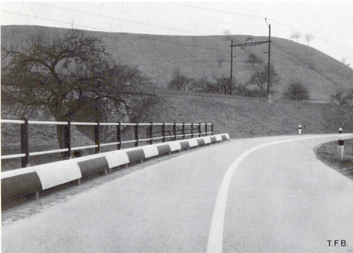
Abb. 3 Ansicht eines Sicherheitszaunes, befestigt an einer früher sehr berüchtigten Unfallkurve
