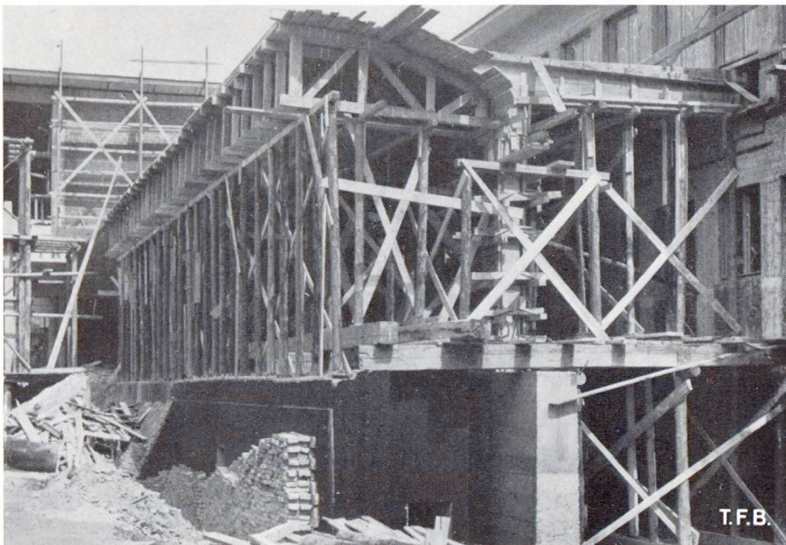
Abb. 2 Schalung einer seitlichen Perron-Überdachung. Dahinter Verwaltungsgebäude in massiver Betonskelett-Bauweise
