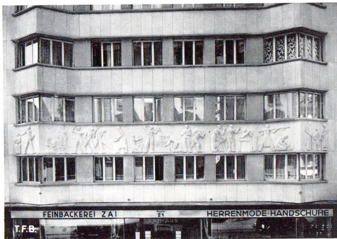
Abb. 1 Fassadenverkleidung und Reliefband aus Kunststein
