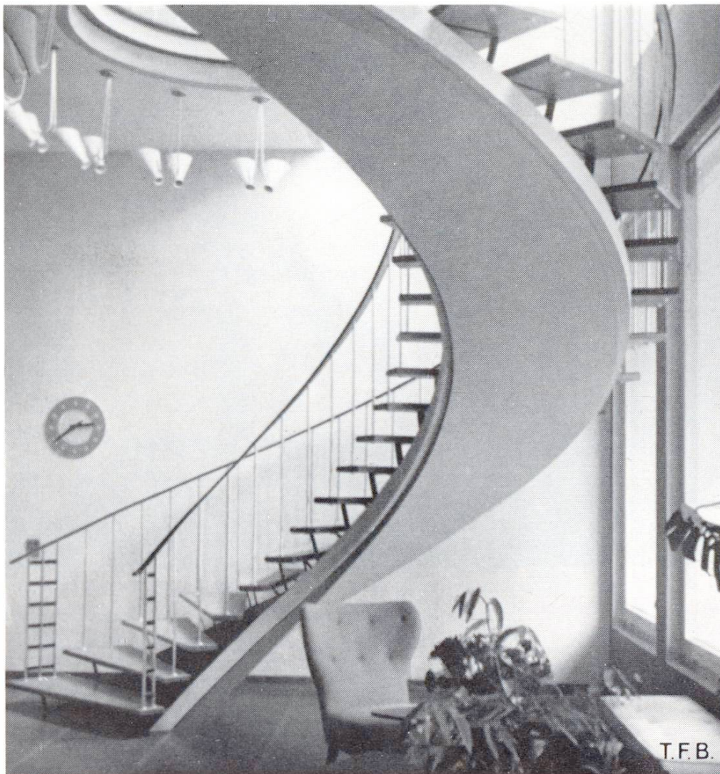
Abb. 3 Treppe in einem Verkaufsgeschäft. Auf einem Tragband aus Beton sind hölzerne Stufen befestigt
