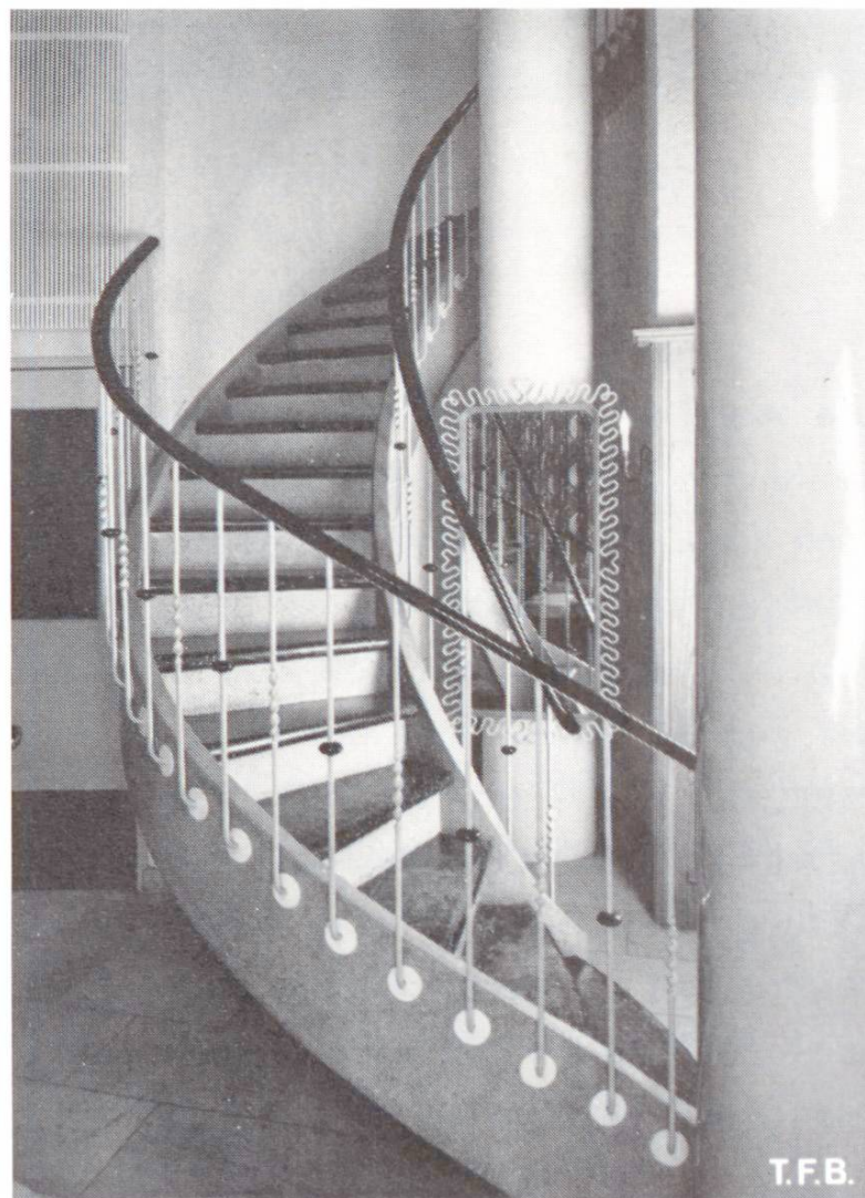
Abb. 5 Wangentreppe aus geschliffenem Kunststein in einem Restaurant. Die Stufen sind mit Gummi überzogen (Aufnahme: O. Pfeifer, Luzern)
