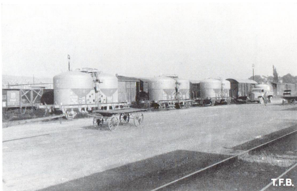
Abb. 1 Umschlagsplatz für Silo-Cement auf dem Hauptbahnhof Zürich. Drei Behälterwagen der SBB zu je 2 \times 13 t Portlandcement
