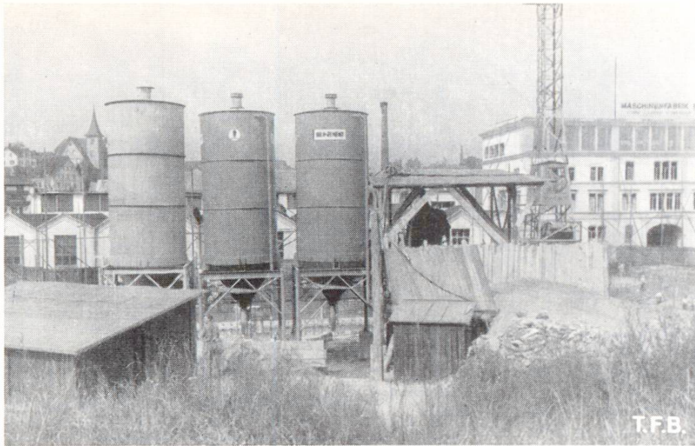
Abb. 6 Cementsilo-Batterie auf einer Grossbaustelle
