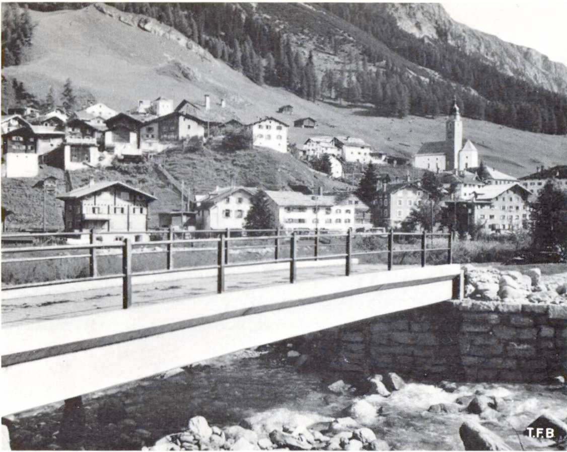
Abb. 3 Kleine Brücke aus vorfabrizierten Betonbalken. Spannweite 13 m
