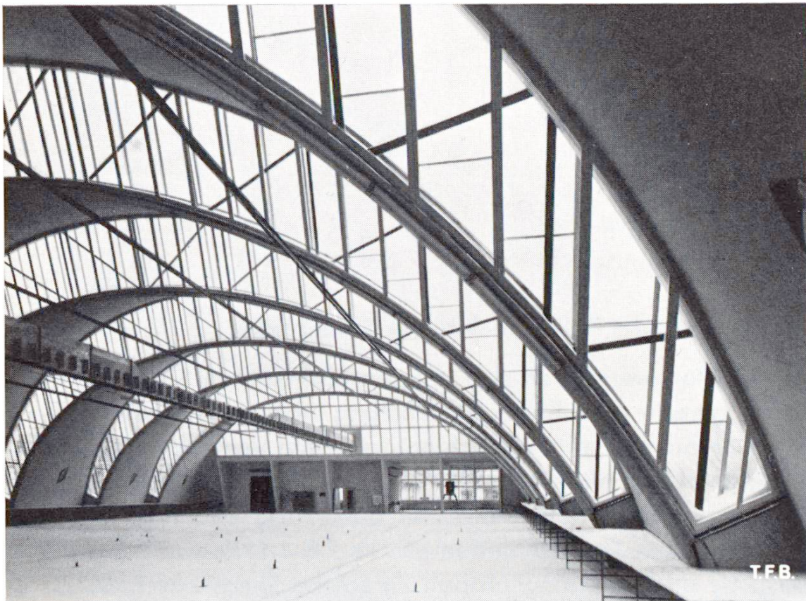
Abb. 6 Blick ins Innere der Zylindershedhalle gegen Norden. Die einzelnen Bogen folgen sich in Intervallen von 7 m und haben eine Spannweite von 28,6 m
