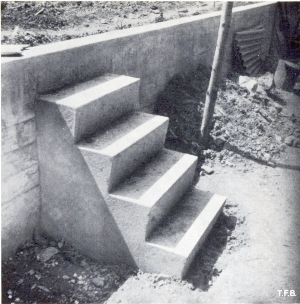
Abb. 3 und 4 Kleinere Umgebungsarbeiten in Beton
