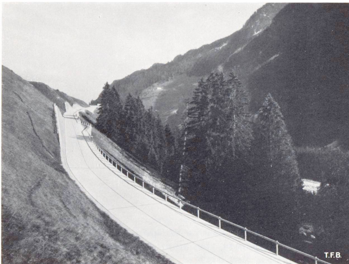
Abb. 3 Schon an der Rampe gegen den Talgrund des Vorderrheines, zwischen Pt. 1126 und 1066 waren hohe Stütz- und Futtermauern zu errichten. Das Bild gibt einen Begriff von der ausgezeichneten optischen Führung, welche die Betonstrasse vermittelt
