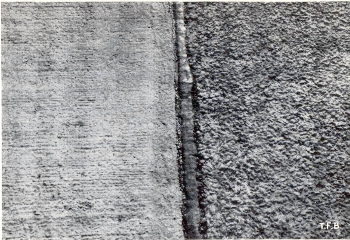
Abb. 4 Oberflächenstruktur eines gewöhnlichen Beton-Strassenbelages und eines Rauhbelages für spezielle Strassenverhältnisse. Der Rauhbelag besteht z. B. aus einer 3 cm dicken Schicht einer Betonmischung P 450 mit ausgesuchtem gebrochenem Steinmaterial \frac{3}{8} mm ohne Sand
