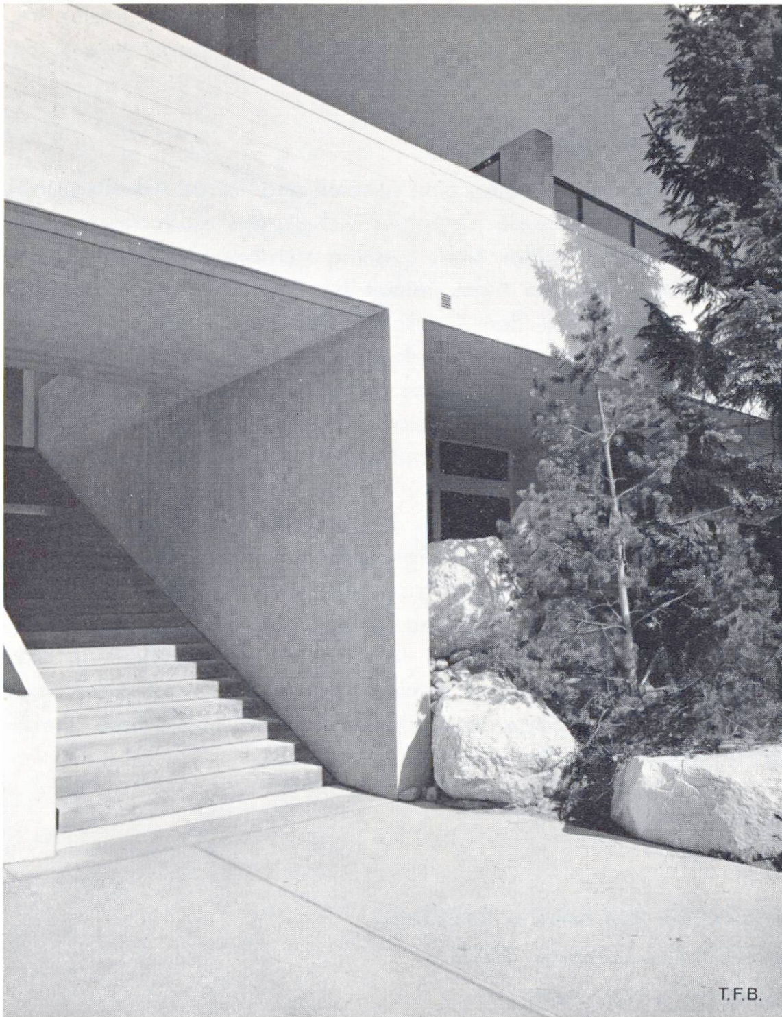
Abb. 3 Eingangspartie zum offenen Treppenhaus. Natürliches und künstliches Gestein stehen in lebhaftem Gegensatz. Die Treppenstufen wie auch die Abdeckplatte auf der oberen Brüstung bestehen aus Ortsbeton der in einem zweiten Arbeitsgang eingebracht worden ist
