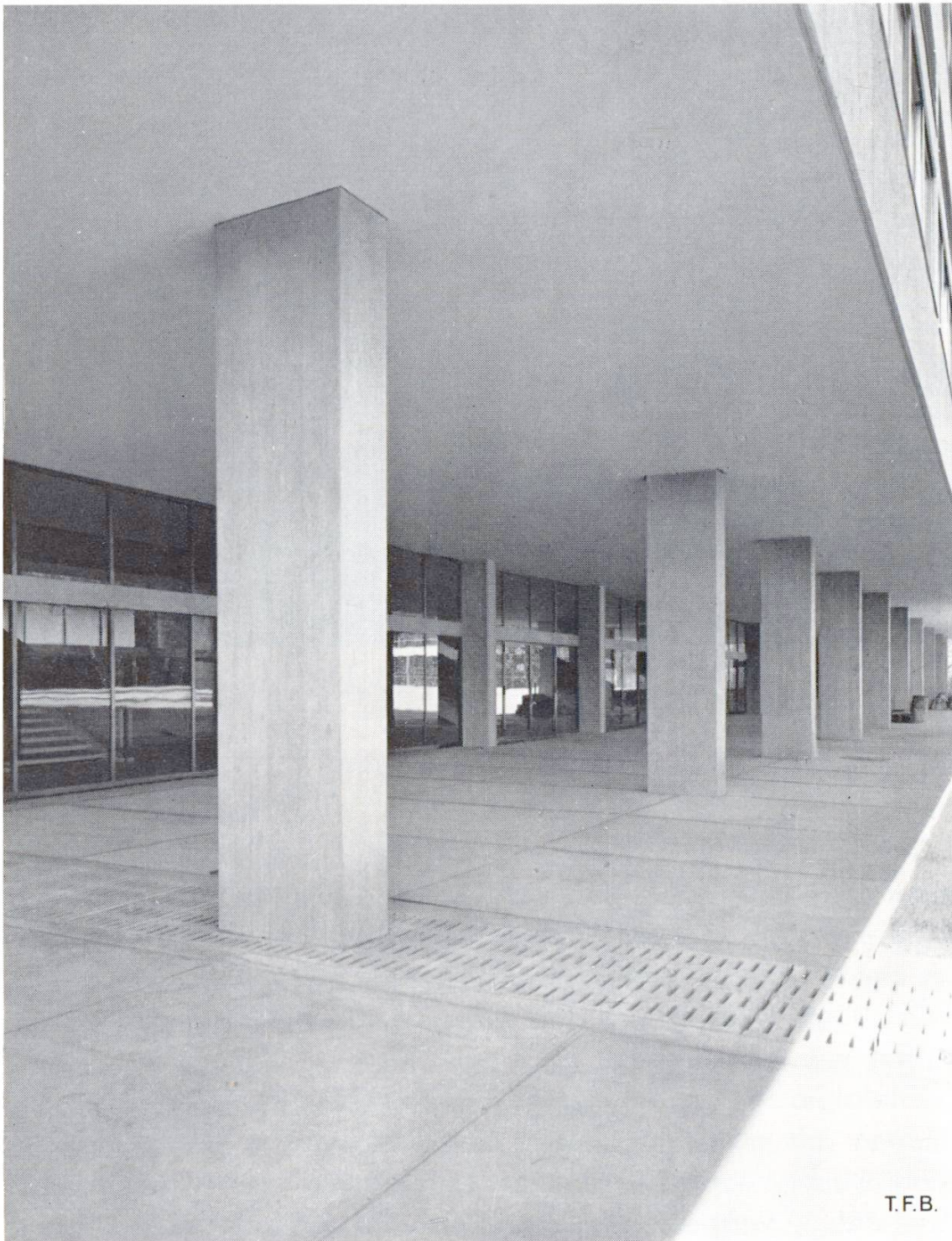
Abb. 6 Säulen in Sichtbeton
