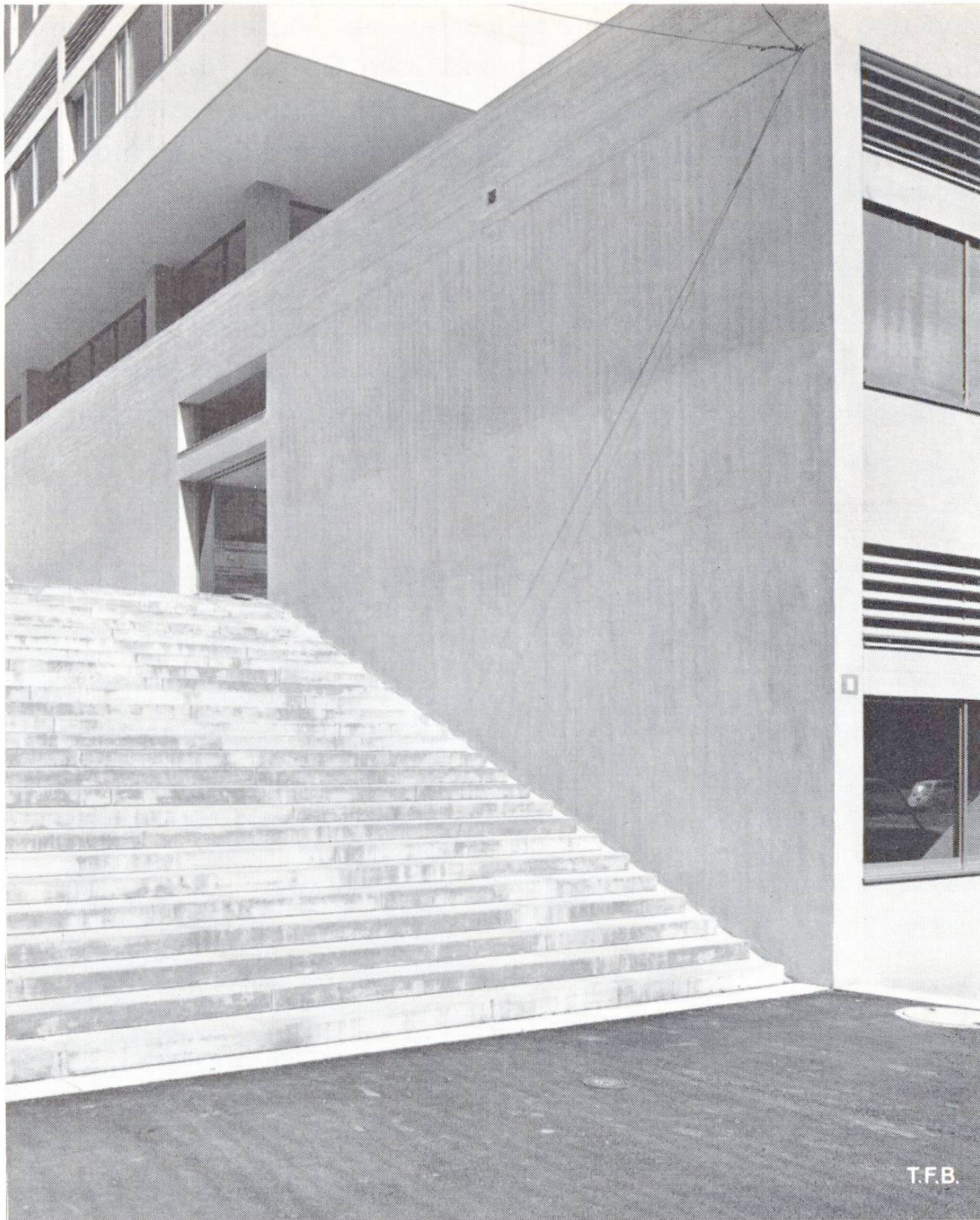
Abb. 7 Grosse Sichtbetonflächen stellen besonders schwierige Probleme hinsichtlich der Gleichmässigkeit. Die kleinsten Unterschiede in der Mischung, der Struktur oder im Feuchtigkeitsgehalt können als Farbnuancierungen auffallen. Im vorliegenden Falle scheint der obere Wandteil noch nicht denselben Austrocknungsgrad erreicht zu haben wie der untere. Die Unterschiede in der Tönung dürften sich deshalb mit der Zeit ausgleichen
