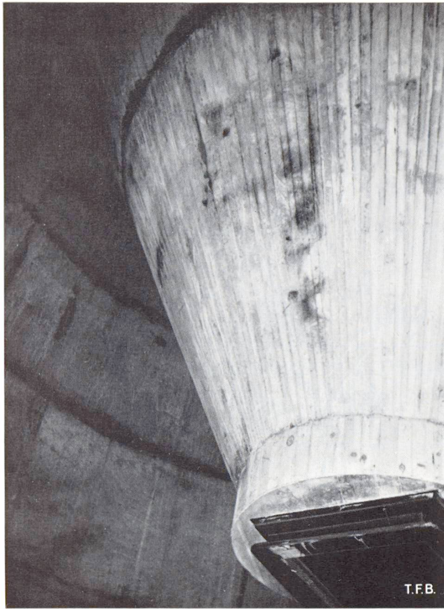
Abb. 5 Aschentrichter und Schieber des Kamins «Jura»
