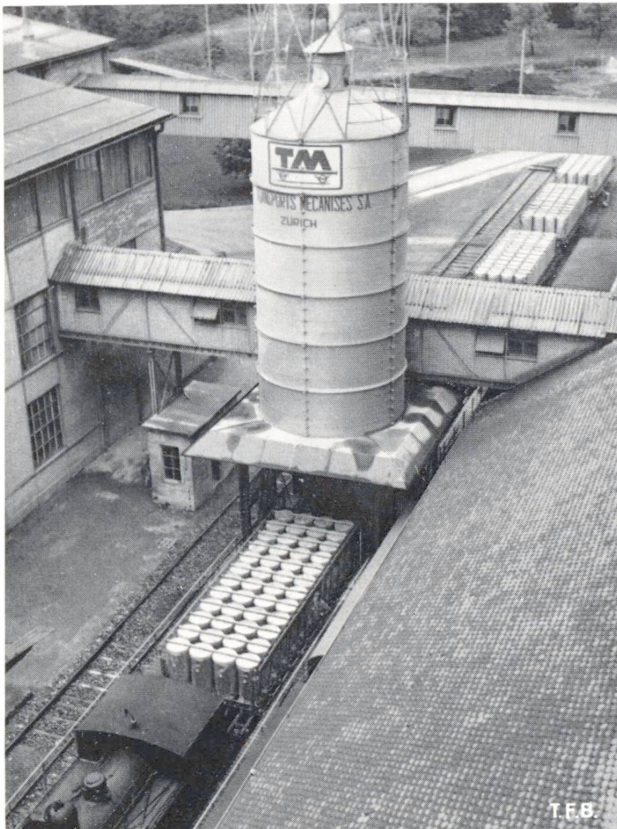
Abb. 3 Der Beschickungs-Silo der «Transports Mécanisés» mit den je 400 kg fassenden Blechkübeln auf den offenen Spezial-Güterwagen
