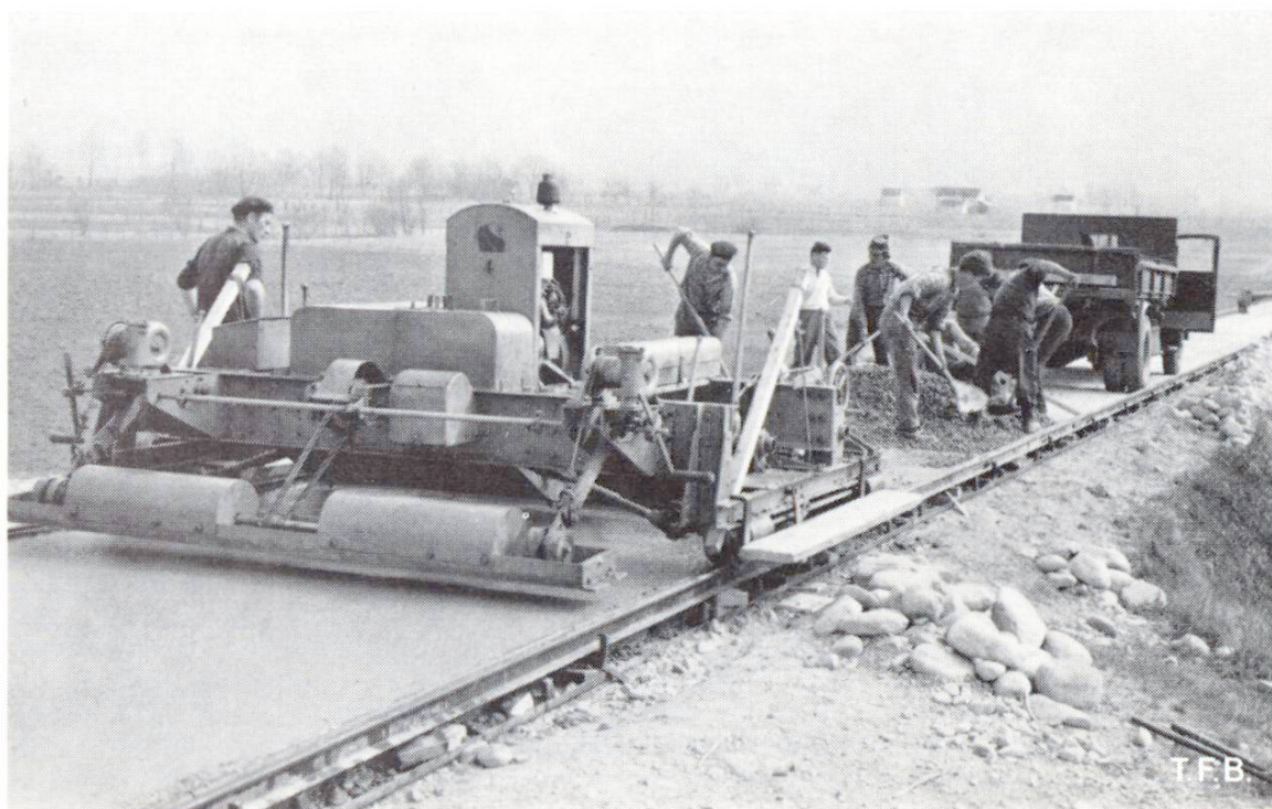
Abb. 4 Maschineller Einbau des Betonbelages. Normalerweise ist die Betonplatte 12 bis 14 cm dick und leicht armiert. Der Baufortschritt beträgt zirka 150 bis 250 m pro Tag
