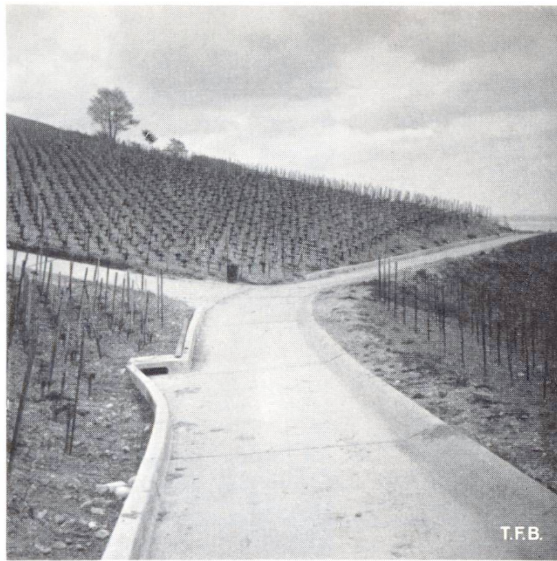
Abb. 5 Auch in schweizerischen Rebbergen sind bisher viele Kilometer betonierter Wege erstellt worden. Sie helfen hier gleichzeitig der berüchtigten Ausschwemmung des Bodens bei starken Regenfällen zu steuern, indem sie abfließendes Wasser sammeln und ableiten
