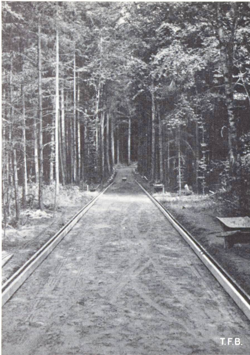
Abb. 1 Planie und Schalungs-Vorbereitung zur Betonierung eines Güterweges im Walde, Kanton Waadt
