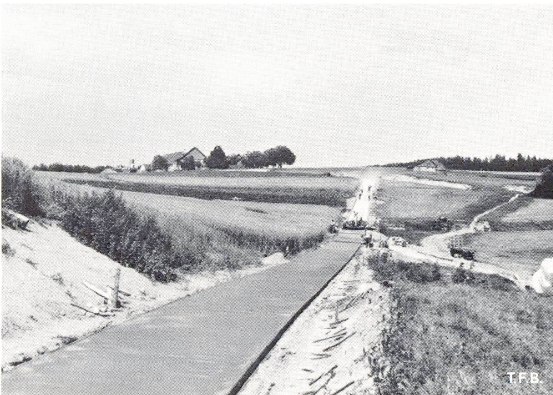
Abb. 2 Bau eines betonierten Güterweges in hügeliger Landschaft, Kanton Waadt
