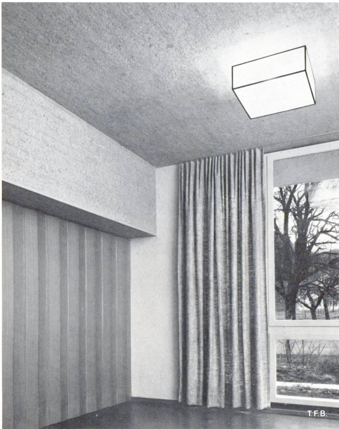
Abb. 2 Decke und Unterzug in einem Nebenraum der Kirche. Solche Sichtbetonflächen sind auch im Innenraum mit guter Wirkung anwendbar. Es haftet ihnen nichts Kaltes und Abweisendes an
