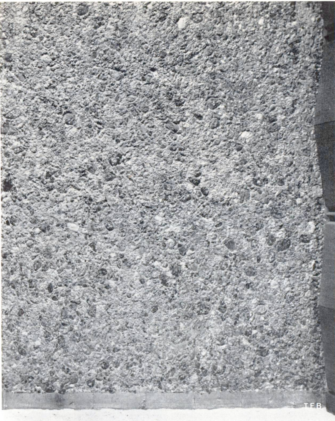
Abb. 5 Strukturbild eines gestockten Sichtbetons mit verhältnismässig grobem Zuschlagskorn. Am Fusse der Wand bildet ein unbearbeitet belassener Streifen einen Sockel
