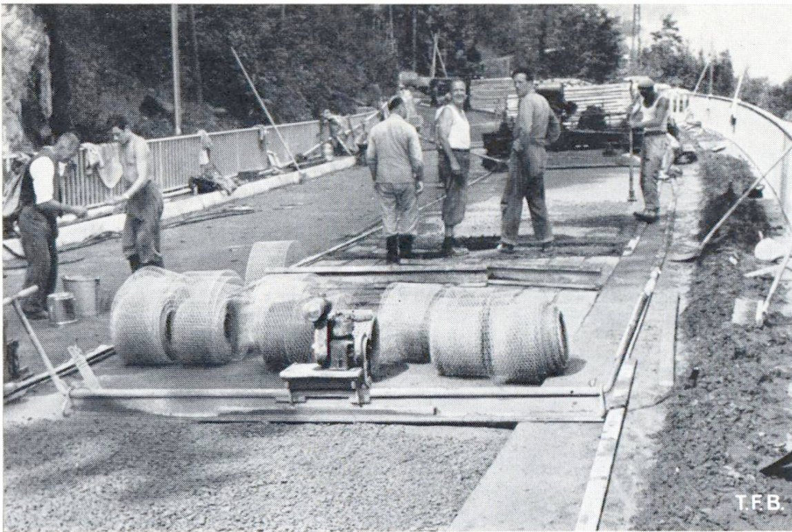
Abb. 3 Heizdrahtnetze vor dem Einbau in den Deckbelag einer Strassenbrücke
